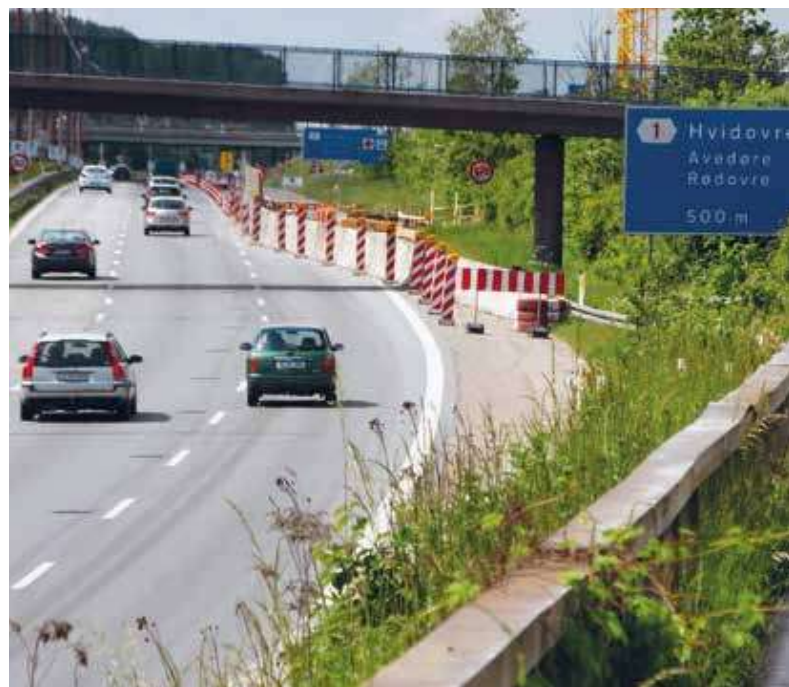
Længdeafmærkningen på kørebanen er ikke demarkeret, og den fungerer derfor som ledelinjer, der fører trafikken ind i trafikvænet.
