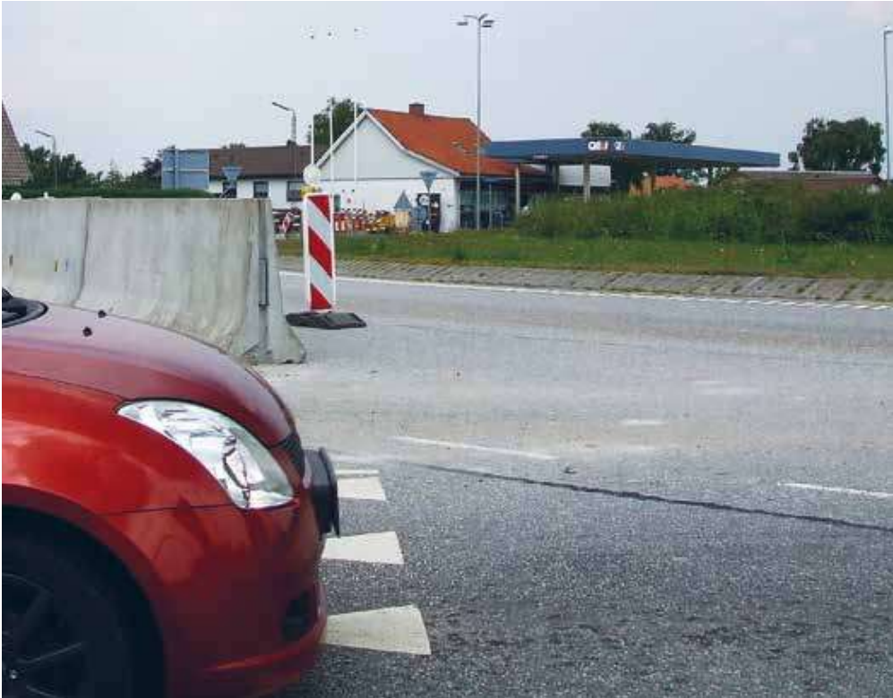
Der er placeret et trafikværn i oversigtsarealet ved en af rundkørselens tilfarter. Trafikværnet er højere end personbilistens øjenhøjde, og indkørsel i rundkørslen sker derfor i blinde.
