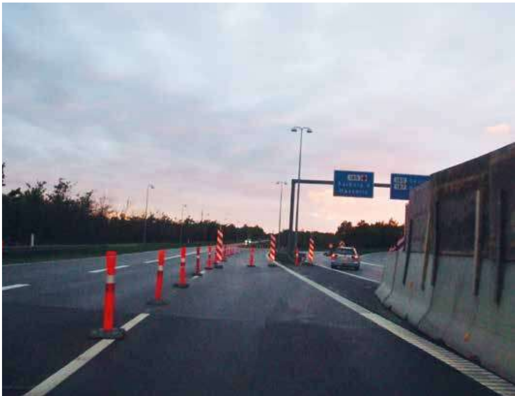
Tilbageledningen fremstår ikke som en "mur", og der er derfor risiko for, at trafikanter - især ved dårlige lysforhold - ikke erkender tilbageledningen og dermed ender som spøgelsesbiler.
